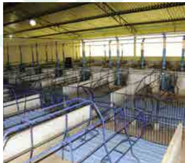
Foto 1 – Sala maternidade limpa para alojamento de matrizes pré-parto
