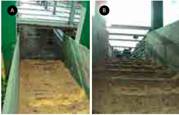
Foto 3 A e B – Embarcadouro com piso antiderrapante coberto por material que reduz a umidade
