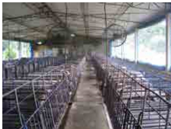
Foto 7 – Sistema de climatização através de túnel de pressão negativa associada ao uso de painéis evaporativos
