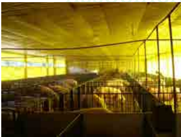
Foto 6 – Sistema de climatização através do uso associado de ventiladores e nebulizadores
