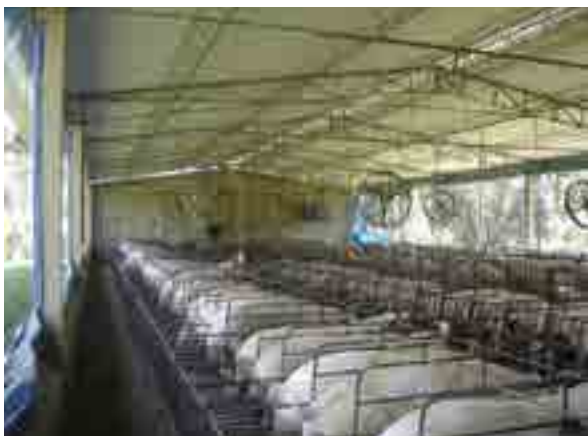
Foto 5 – Sistema de climatização através do uso de ventiladores
