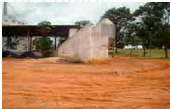
Foto 1 – Área de acesso à propriedade livre de dificuldades durante o deslocamento e manobras para estacionar junto do embarcadouro
